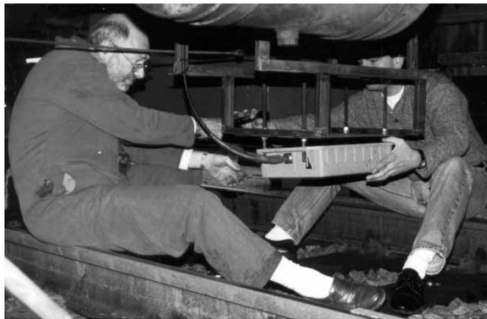
Abb. 13.22 Montage einer Leseantenne für EURO-Balise an einem Triebfahrzeug.
