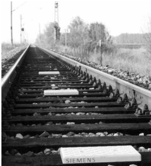
Abb. 13.21 EURO-Balise im praktischen Einsatz. (Foto: Siemens Verkehrstechnik, Braunschweig)
